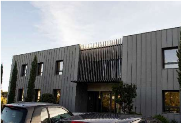
Façade en bardage aluminium. Menuiseries Aluminium avec système Oscillo battant BUREAU EDF
